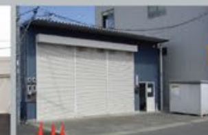
第三溶接ブース
